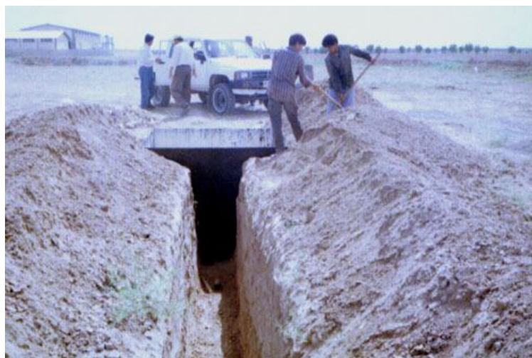
تصویر 2- نمایی از استقرار لایسیمتر قیراندود شده و پر کردن لایسیمتر
