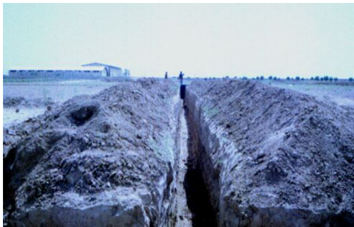
تصویر 1 - نمایی از کانال حفر شده جهت استقرار لوله زه آب
